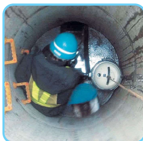
下水道管を調査している様子
