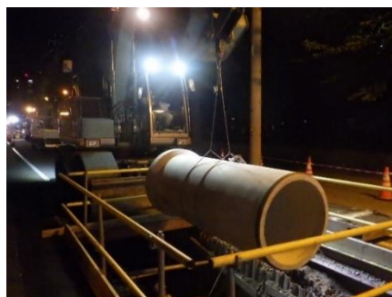
管路の耐震化（管路の入れ替え）
