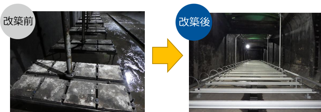
機械設備の改築（散気装置）
