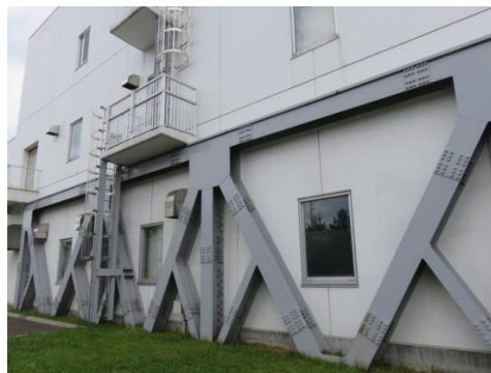
揚水施設の耐震化（外部補強）
