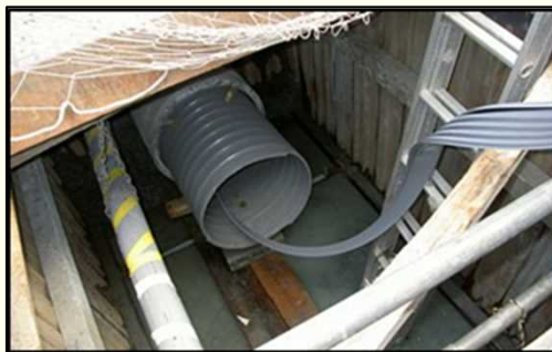
管更生工法による改築
