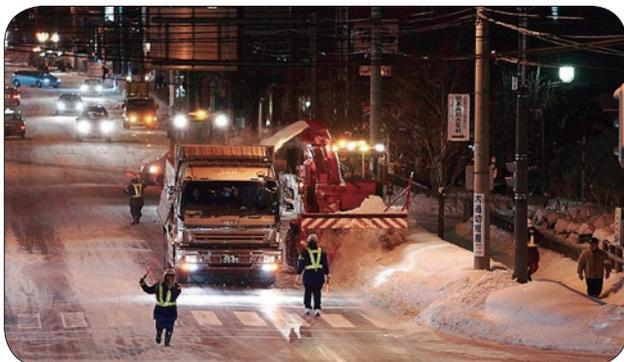
道路わきに積みあげられた雪を、大型のロータリー除雪車などでダンプカーに積んで、雪たい積場まで運びます。バスが通る道路や交通量が多い道路などで行われます。
