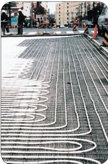
道路の中に電気や温水などのパイプを入れて、その熱で雪をとかし、車が安全に走れるようにしています。
