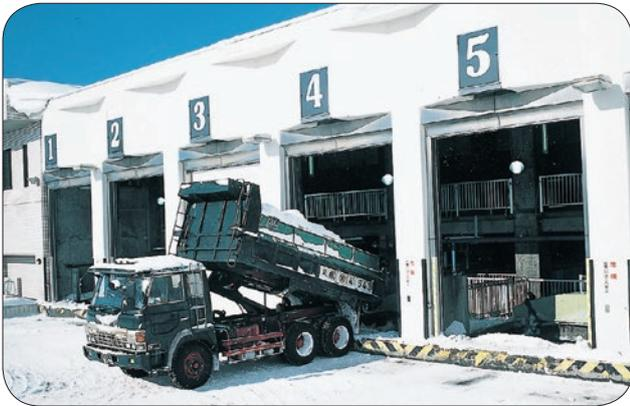
みずさいせい 水再生プラザから出る処理水を利用して、雪をとかします。
