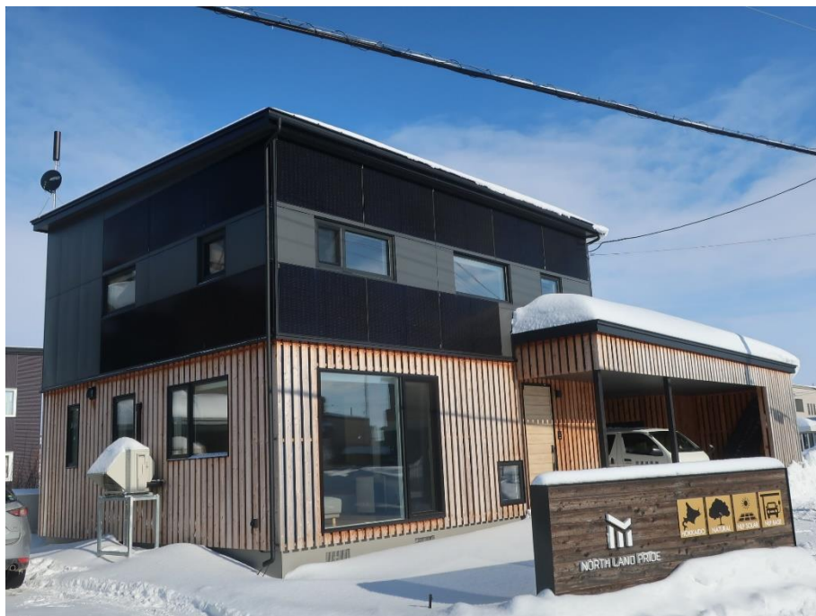
壁面太陽光発電の事例（札幌市内）
