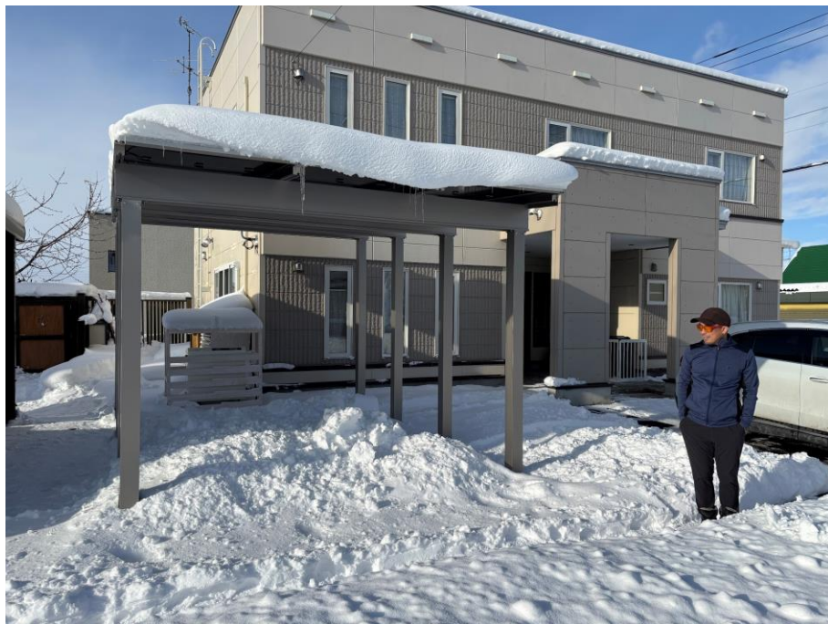
カーポートの屋根を両面発電の太陽光パネルにした事例 (東川町)
