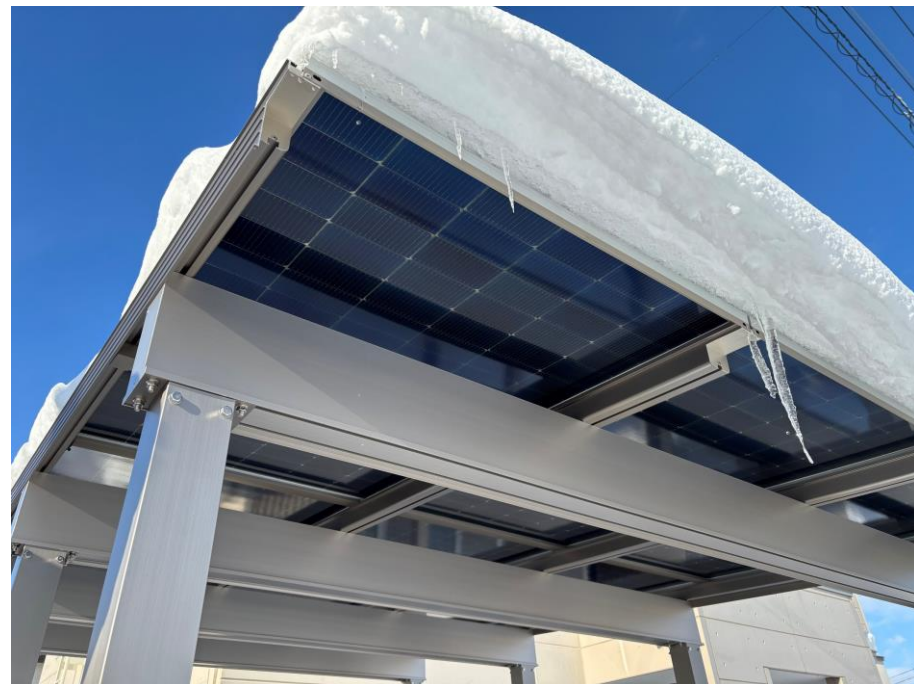
カーポートの屋根を両面発電の太陽光パネルにした事例 (東川町)
