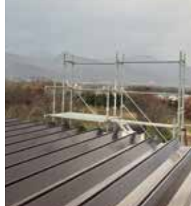
パネル設置前の屋根の様子。
