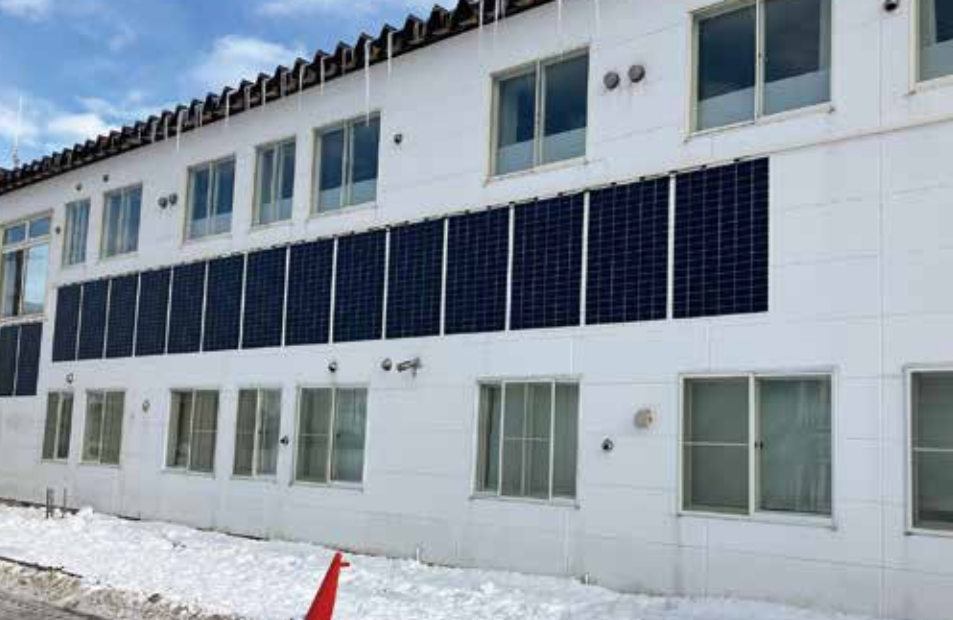
壁面への太陽光パネル設置が実現。
