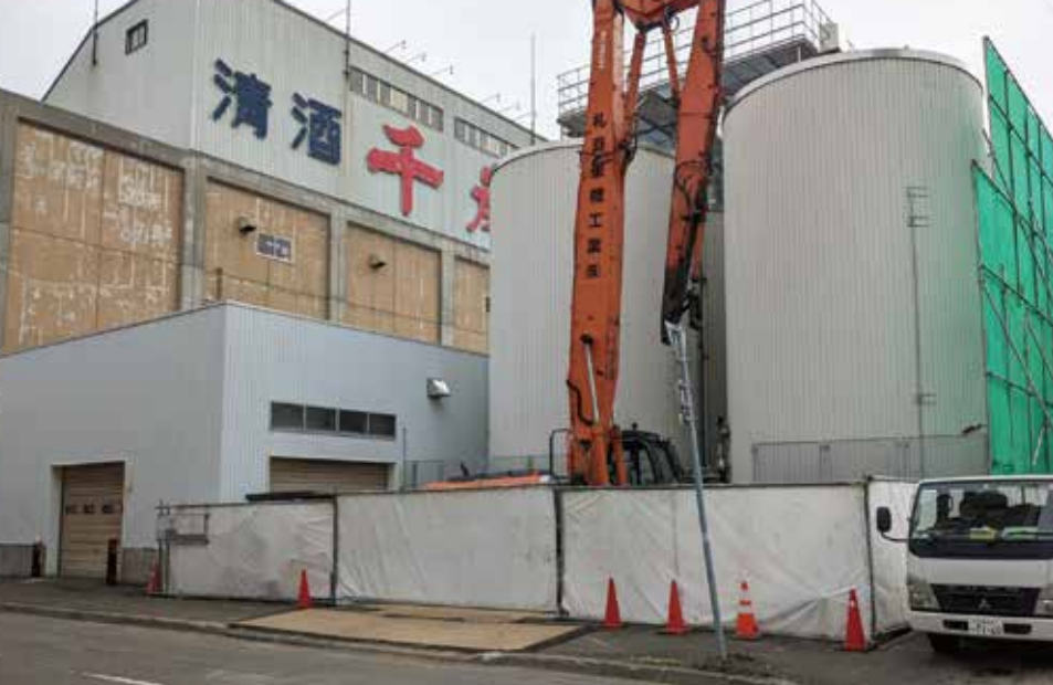
旧蔵の解体の様子。大きなタンクが見える。
