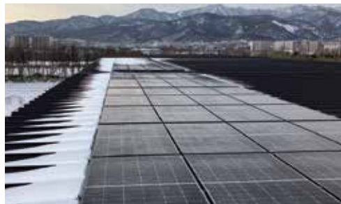
パネル設置後。追加設置も検討中だ。
