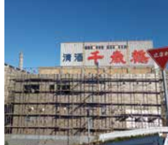
新蔵建設中の様子。
