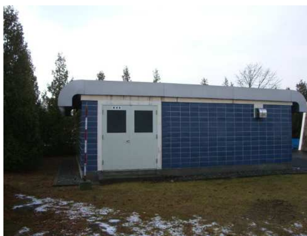
管理事務所裏側機械室
