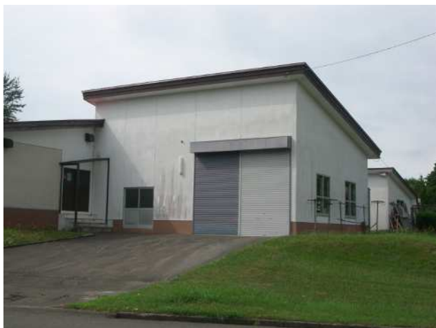
裏口併設の車庫兼倉庫
