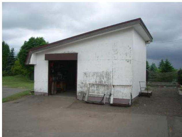
管理事務所裏側倉庫
