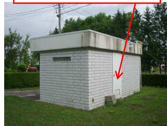
トイレ裏側の様子
