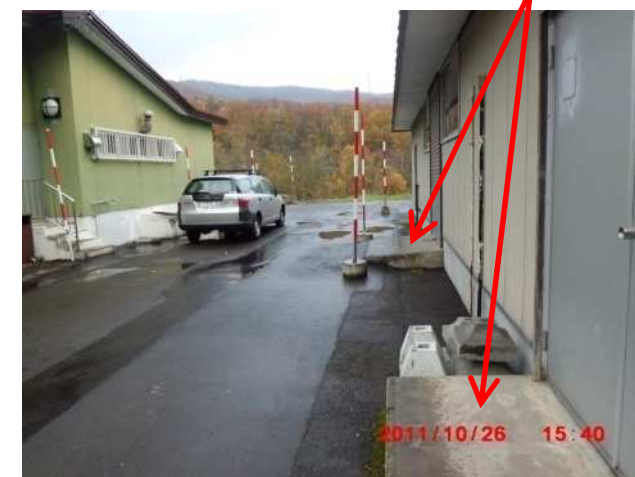
ポンプ室兼倉庫前の様子
