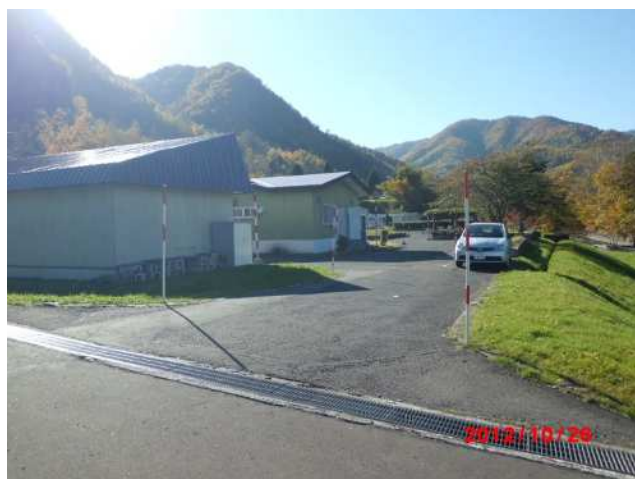
管理事務所進入路
