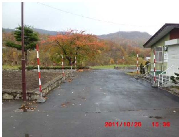
管理事務所正面右から進入路方向
