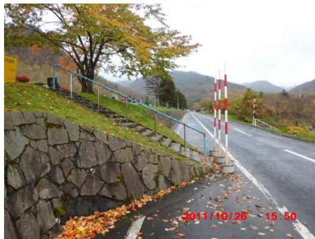
B-2号の突出している階段（図面番号①）
