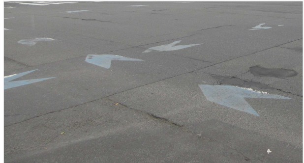
図-22 矢羽根型路面表示の劣化状況（交差点部）
