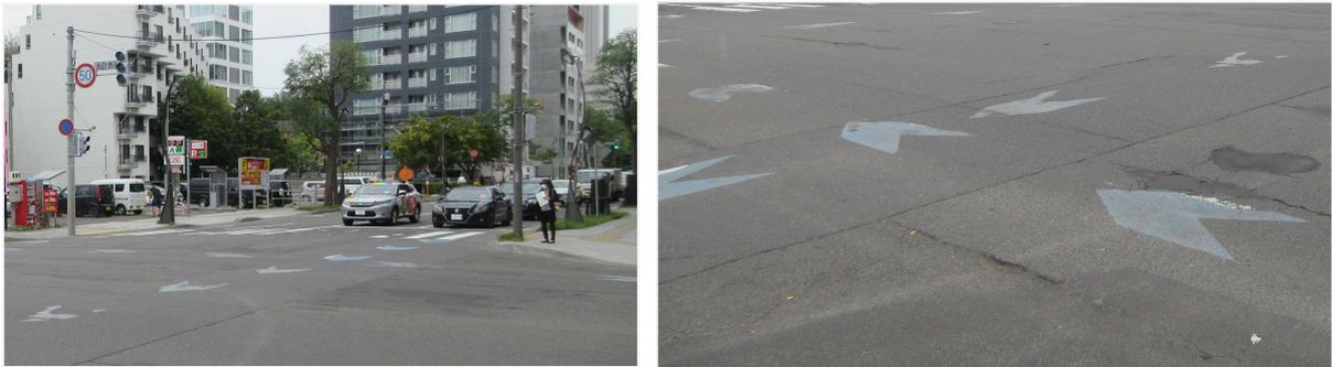
図-22 矢羽根型路面表示の劣化状況（交差点部）
