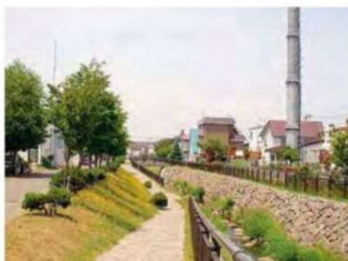
■スロープにより水辺に近づける安春川(北区) 縦断方向にスロープを設けて水辺に近づけるようにした
