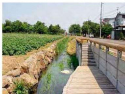
■水辺へのアクセスを改善した屯田第1排水(東屯田川上流)(北区) 限られた敷地でも工夫次第で、水辺へのアクセスが改善できる
