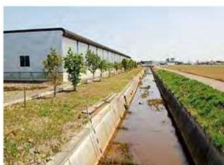
■コンクリート三面張りの川 (丘珠5号川:東区) 流れが一律で、横断的な変化が無い
