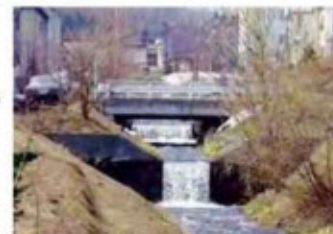
■中の川の改修前の落差工
