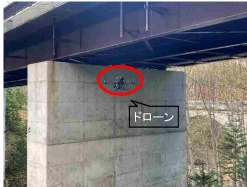
ドローンを使った橋梁の点検
