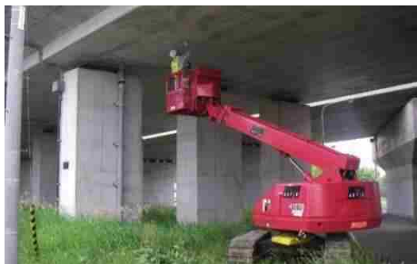
橋梁点検の実施
