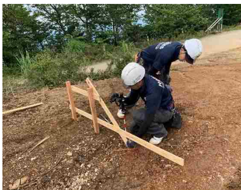
ICTを活用した丁張作業
