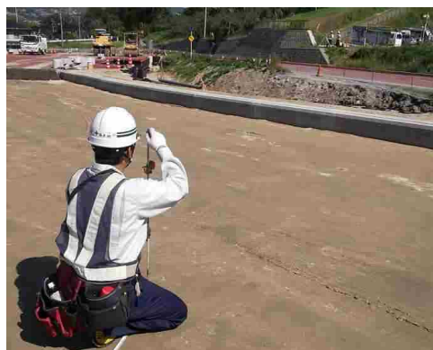
ICTを活用した出来形管理
