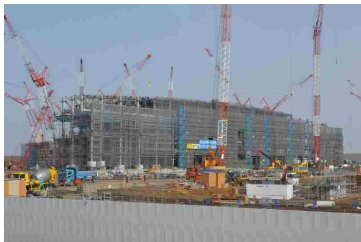
半導体製造工場(千歳市)の建設状況(写真提供:北海道建設新聞社)
