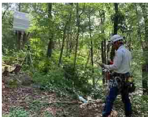
ICTを活用した起工測量
