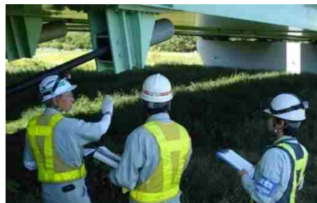
橋梁の緊急点検訓練
