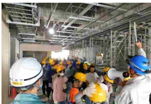
学校改築工事における現場体験会
