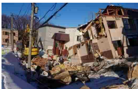
平成 30 年北海道胆振東部地震での被災家屋の除去
