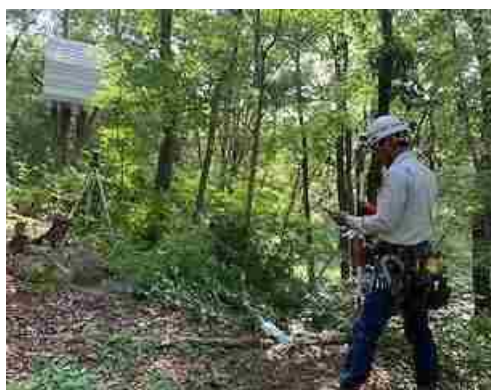
ICTを活用した起工測量
