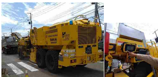
ICT舗装工（修繕工）
