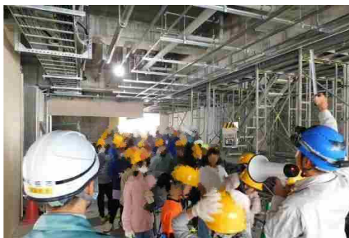
学校改築工事における現場体験会
