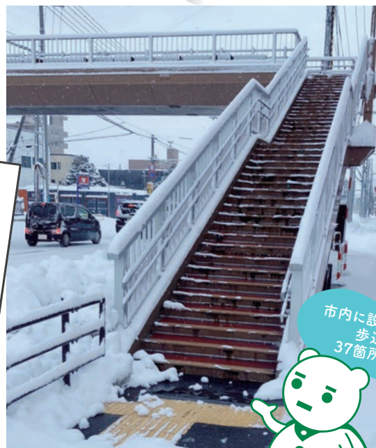
手稲東小学校前歩道橋
