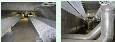
地下歩行空間への熱導管整備状況
