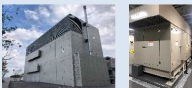
北4東6に整備されたエネルギーセンター
