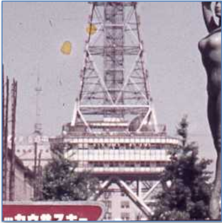
【図1】テレビ塔の脚部 当館所蔵写真 AY00314(昭和 35 年 7 月撮影)を部分拡大
