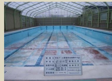
築16年 プール槽の塗装の劣化
