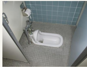
床がタイル敷きの和式便器
