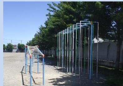
塗装が剥離し老朽化した遊具
