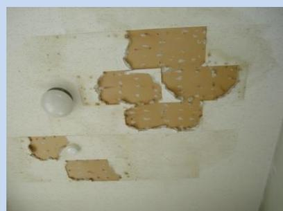
漏水による天井材の劣化
