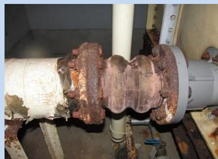
給水設備の老朽化
