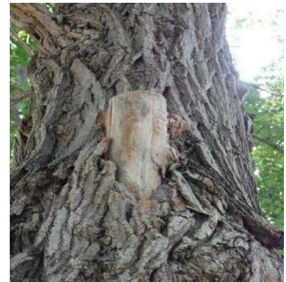
【西側】上部剪定痕からの腐朽
