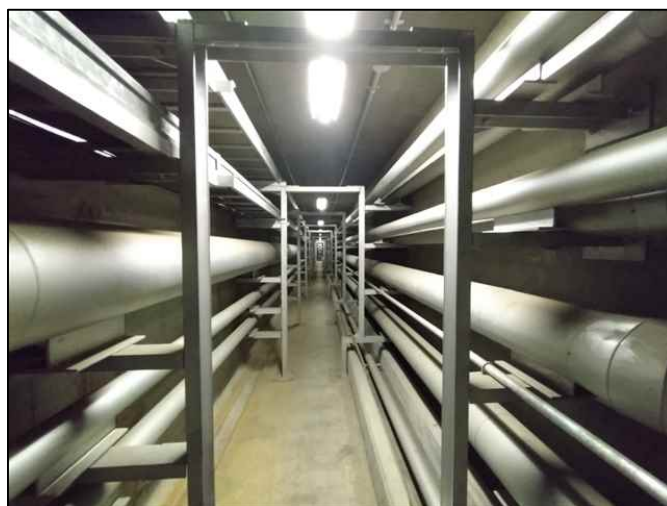
図 2.7 既設共同溝姿（発寒破碎工場側より現発寒清掃工場側を撮影）
