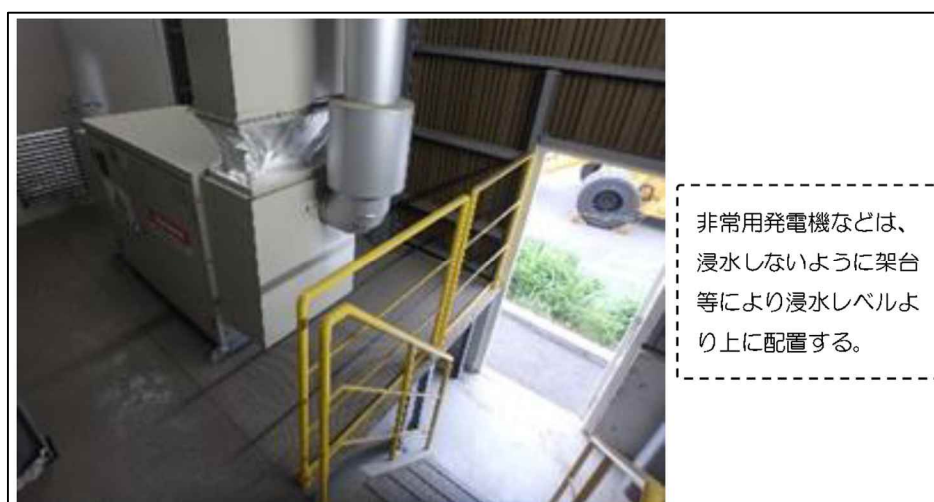
図 6.8 非常用発電機の浸水対策の事例
