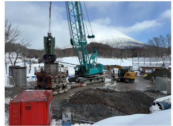
岩塊撤去状況
