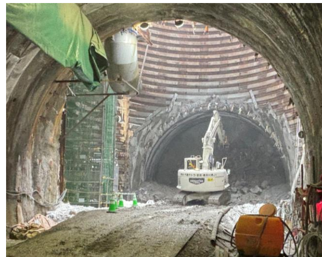
到達立坑からNATM掘削状況
