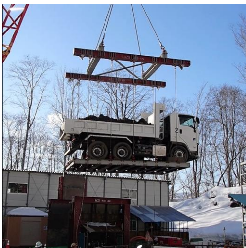
発生土搬出状況(到達立坑部(地上部))
