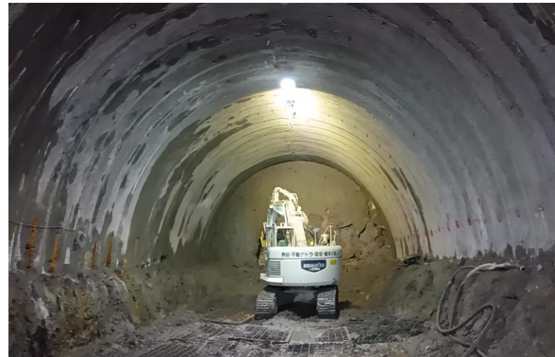
NATM掘削状況
