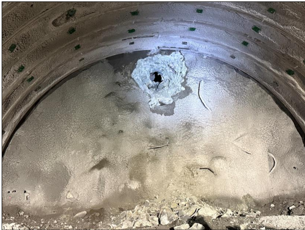
掘削完了地点の状況
