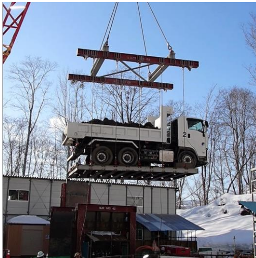
発生土搬出状況(到達立坑部(地上部))
