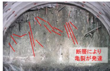
【特徴1】断層運動に伴う弱部の形成
