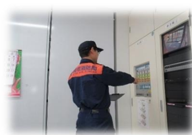
建物への立入検査
