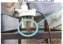
土中に近い部分の配管が腐食し、灯油が漏えいした。
