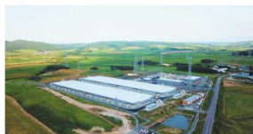
▲豊富町には世界最大級の蓄電池がある 写真提供:北海道北部風力送電(株)
