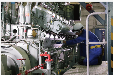
点検・調査と修繕
