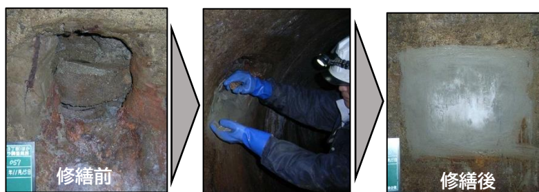
【修繕の例（コンクリート剥離による鉄筋露出の補修）】
