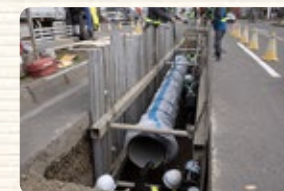
配水管の布設替え
