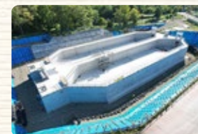
白川新沈砂池の建設
