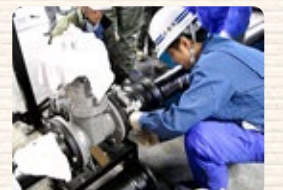
配水管接合実習
