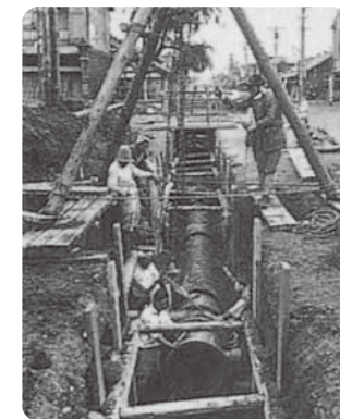
水道管工事のようす
