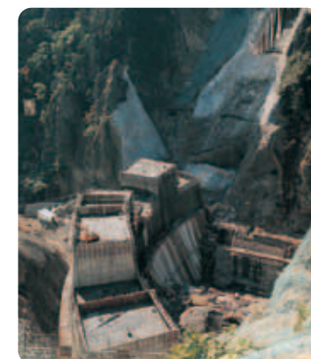
豊平峡ダム工事のようす
