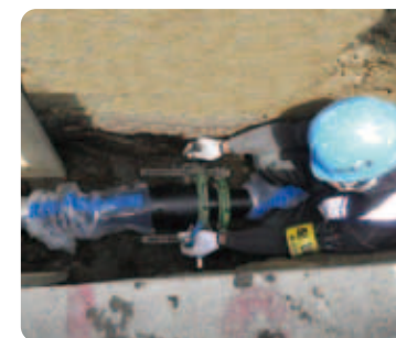
配水管の接合
