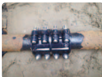
漏水修理完了
