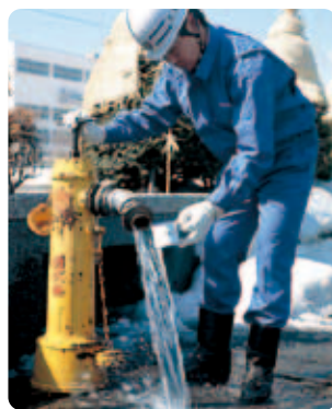
濁水処理作業
