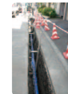
配水管の布設状況
