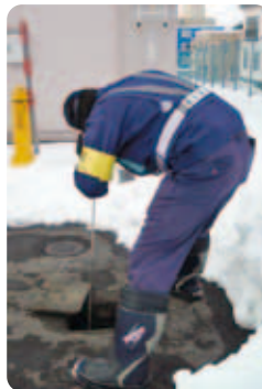
水道メーターの音聴調査
