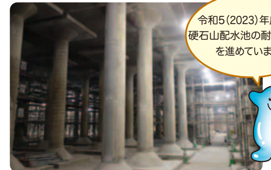
配水池耐震化の状況写真
