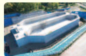
白川新沈砂池の建設
