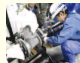
配水管接合実習
