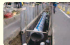
配水管の布設替え
