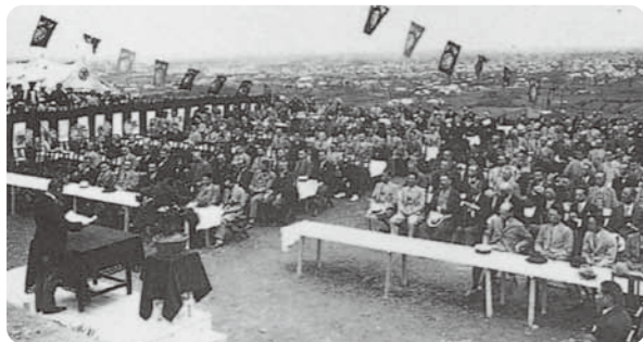
創設水道起工式【昭和9(1934)年】
