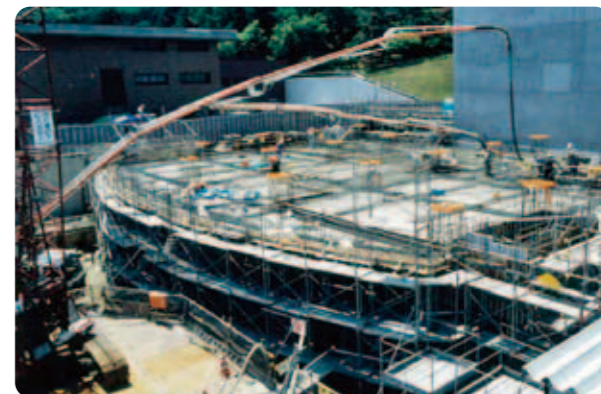
藻岩浄水場改修工事【平成9(1997)~15(2003)年】
