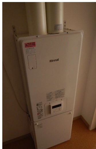
ガス潜熱回収型給湯温水暖房機 (ex.エコジョーズ)
