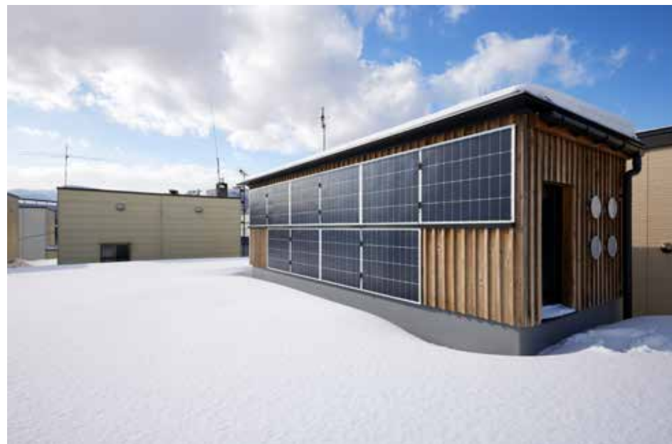
太陽光パネルを設置した塔屋は、この家に導入されているパッシブ換気（※）の排気筒であると同時に、屋根への点検口の役目も果たしている
